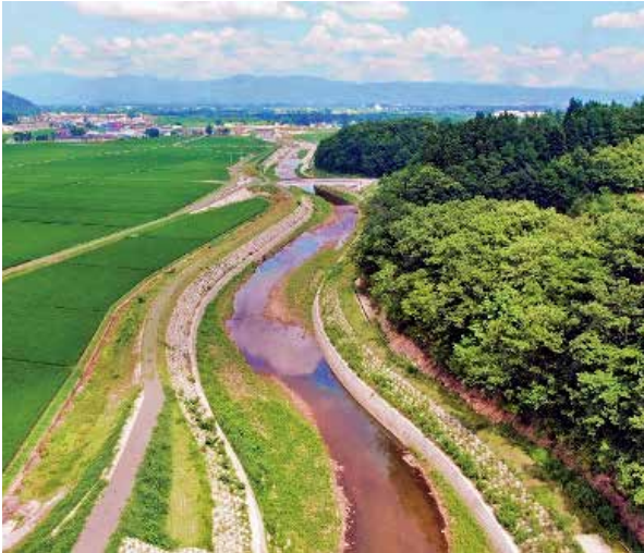
現況の低水路を活かし河川改修した上溝川（横手市）
