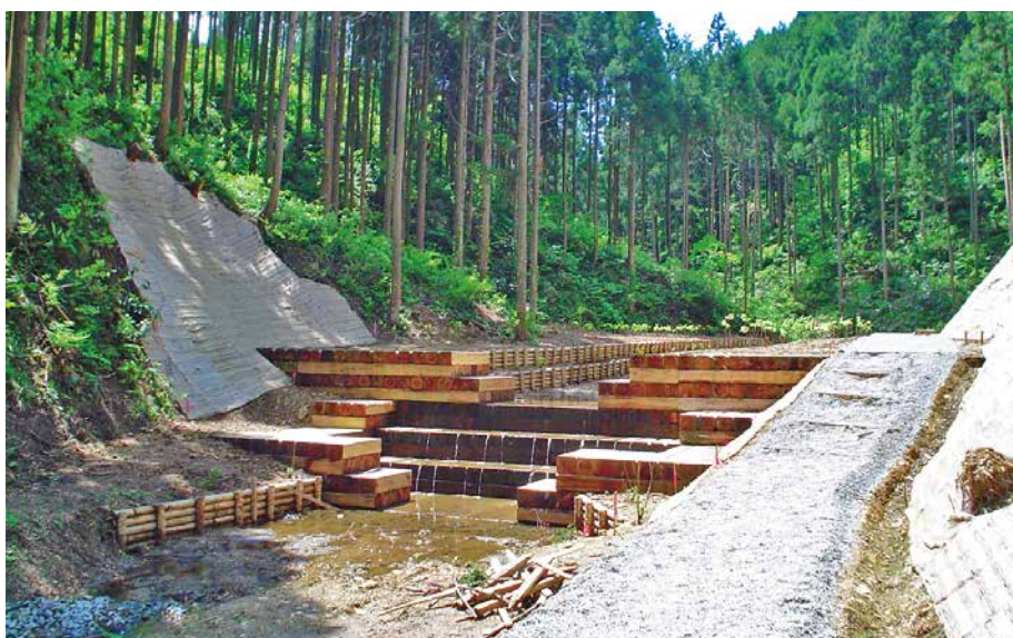
間伐材の利用促進と景観に配慮した木製治山ダム（五城目町）
