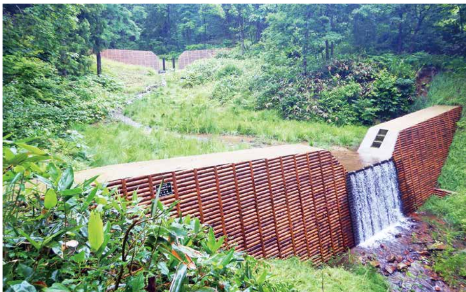
型枠に間伐材を活用した治山ダム（大仙市）
