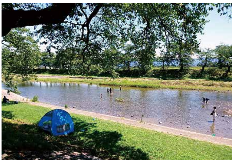
親水性に配慮し階段護岸工を用いた斉内川（大仙市）
