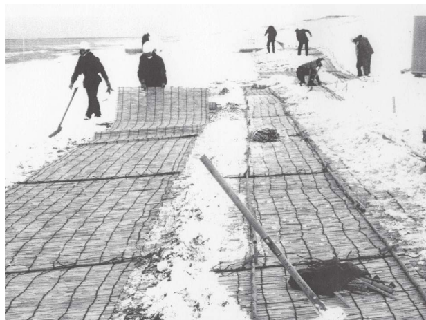
〈治山工事・海岸治山工(山形県・酒田海岸)〉
